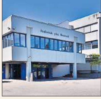
Für den geplanten Neubau sind nun Architekten am Zug.
