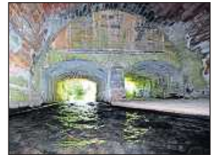
Ein zentrales Element: der Seyerbach. ARCHIVFOTO: MEHN
